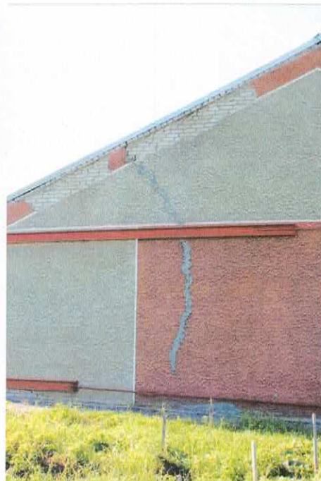
Фото 8.1.13-8.1.15 Трещины в кладке наружных стен и фронтона
