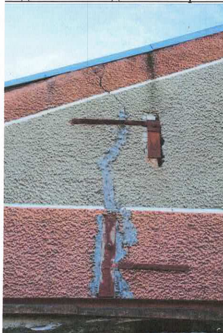
Фото 8.1.8-8.1.10 Наличие трещин в кладке наружных стен и фронтона
