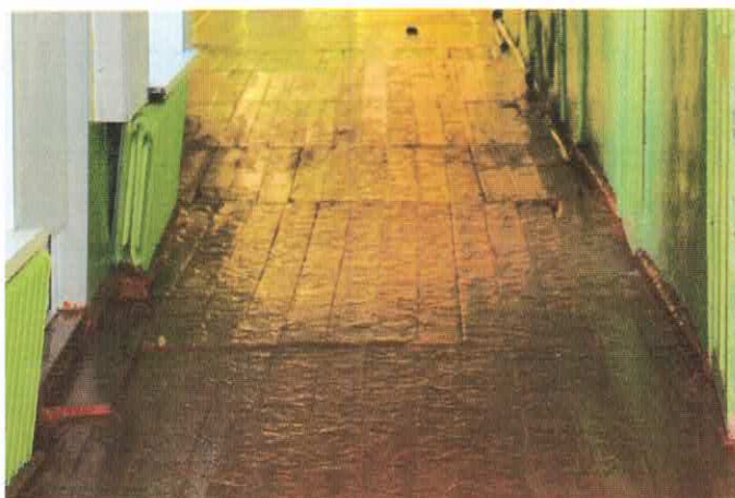
Фото 8.3.7,8.3.8 Деформации дощатого настила пола, общий физический износ
