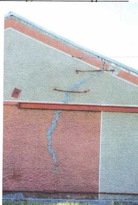
Фото 8.1.11.8.1.12 Трещины в кладке наружных стен и фронтона
