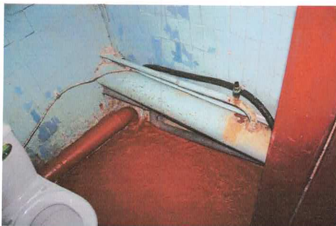
Фото 8.8.1,8.8.2 Коррозия элементов систем водоснабжения и канализации
