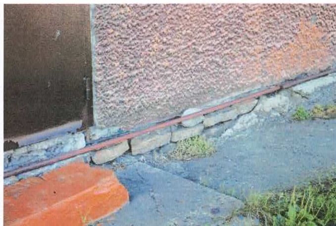
Фото 8.1.1,8.1.2 Наличие пустот в теле бутобетона цокольной части фундаментов
