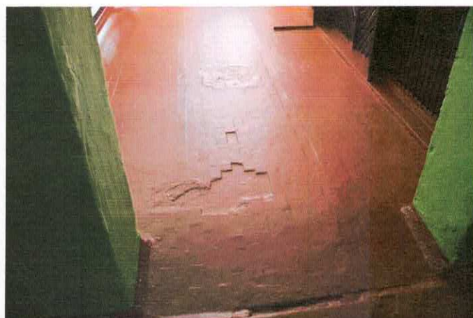
Фото 8.3.9,8.3.10 Отсутствие фрагментов покрытия пола и керамической плитки
