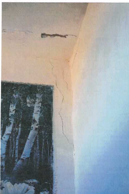
Фото 8.1.16-8.1.18 Трещины в кладке внутренних стен
