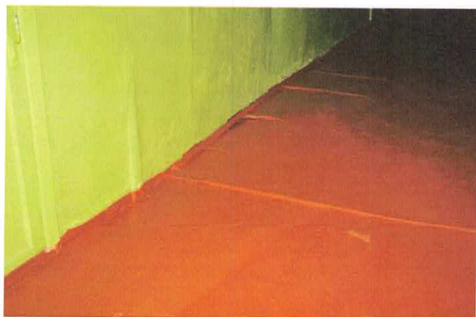
Фото 8.3.5,8.3.6 Деформации дощатого настила пола, общий физический износ
