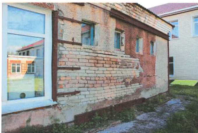
Фото 8.1.1,8.1.2 Выпучивание наружной версты кладки стены
