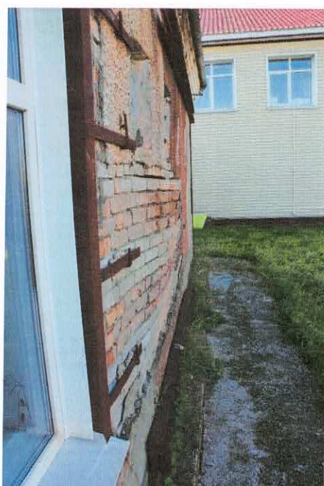
Фото 8.1.3-8.1.5 Выпучивание наружной версты кладки стены
