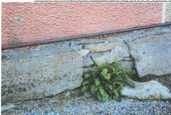
Фото 8.1.3,8.1.4 Наличие пустот в теле бутобетона цокольной части фундаментов
