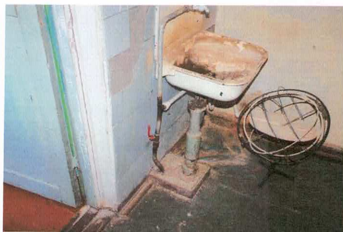
Фото 8.8.1,8.8.2 Коррозия элементов систем водоснабжения и канализации
