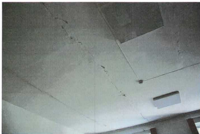
Фото 8.3.1,8.3.2 Трещины в швах между смежными плитами перекрытия, выкрашивание раствора
