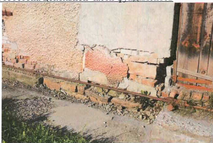
Фото 8.1.3,8.1.4 Наличие пустот в теле бутобетона цокольной части фундаментов
