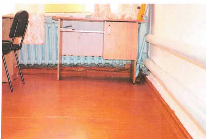
Фото 8.3.3,8.3.4 Деформации дощатого настила пола
