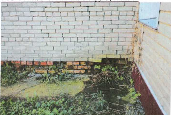
Фото 8.1.5,8.1.6 Разрушение кладки цокольной части фундаментов в результате морозной деструкции
