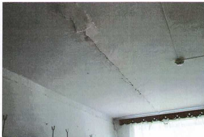
Фото 8.3.1,8.3.2 Трещины в швах между смежными плитами перекрытия, выкрашивание раствора
