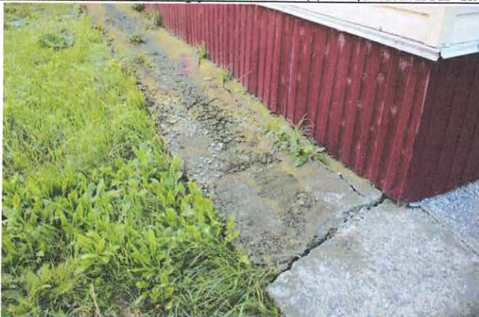
Фото 8.1.7,8.1.8 Разрушение бетона отмостки, наличие трещин в теле бетона
