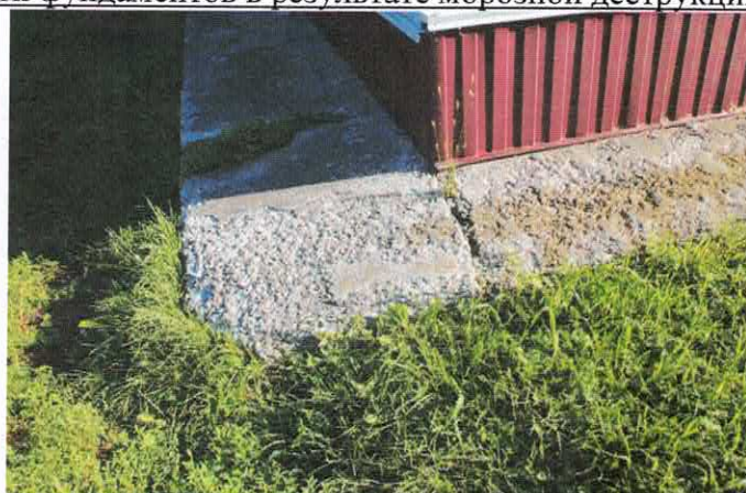
Фото 8.1.7,8.1.8 Разрушение бетона отмостки, наличие трещин в теле бетона
