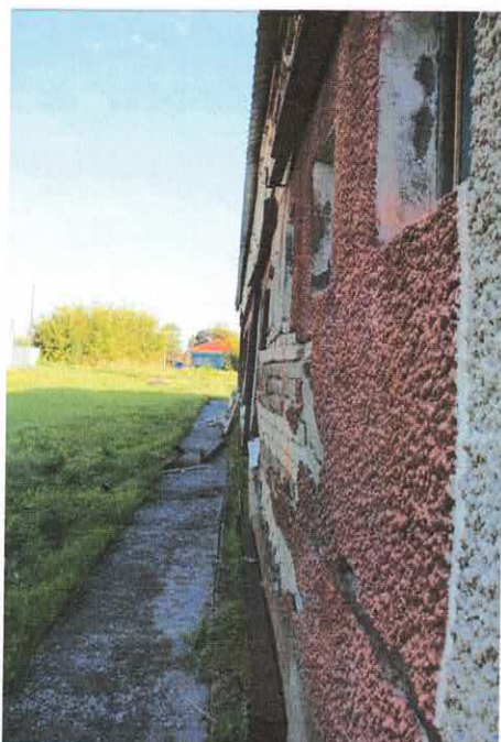
Фото 8.1.3-8.1.5 Выпучивание наружной версты кладки стены
