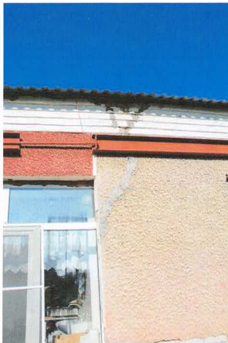
Фото 8.1.13-8.1.15 Трещины в кладке наружных стен и фронтона
