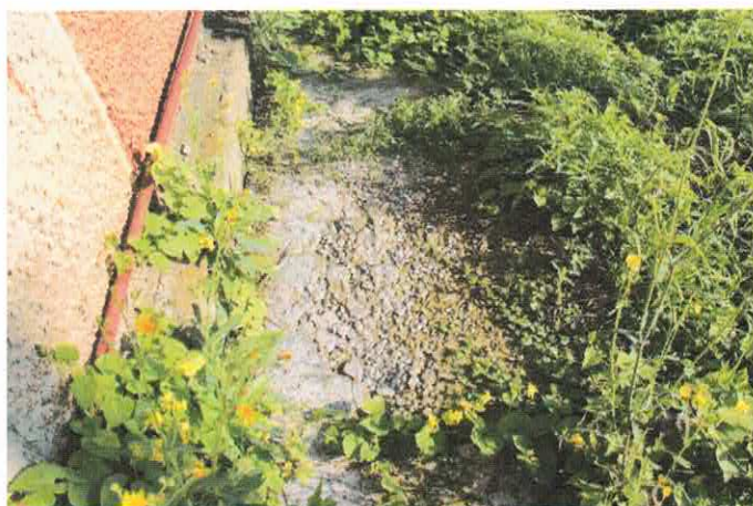
Фото 8.1.9, 8.1.10 Разрушение бетона отмостки, наличие зазоров между отмосткой и цоколем
