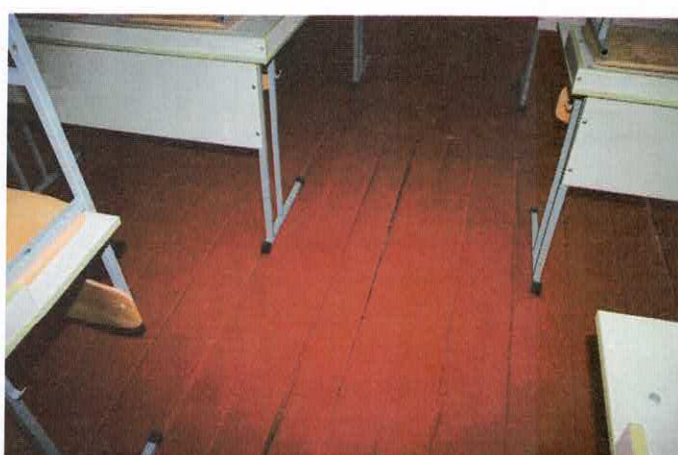
Фото 8.3.5,8.3.6 Деформации дощатого настила пола, общий физический износ
