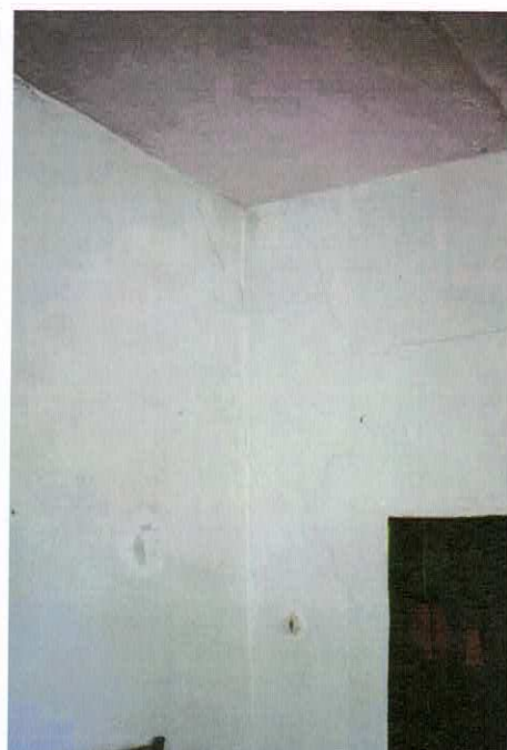
Фото 8.1.16-8.1.18 Трещины в кладке внутренних стен
