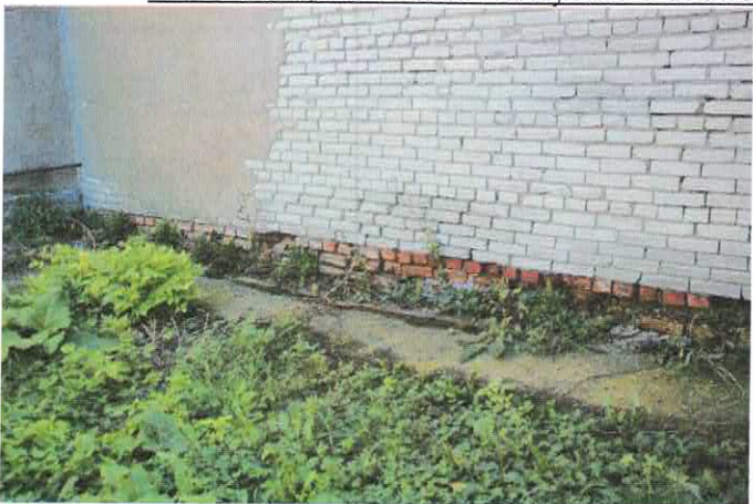
Фото 8.1.5,8.1.6 Разрушение кладки цокольной части фундаментов в результате морозной деструкции
