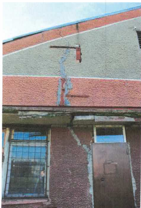
Фото 8.1.8-8.1.10 Наличие трещин в кладке наружных стен и фронтона
