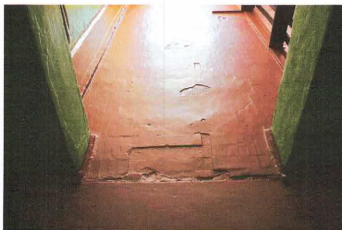
Фото 8.3.9,8.3.10 Отсутствие фрагментов покрытия пола и керамической плитки
