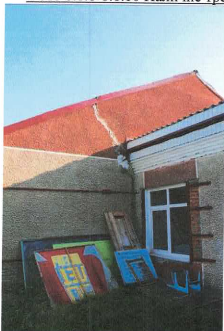
Фото 8.1.11.8.1.12 Трещины в кладке наружных стен и фронтона
