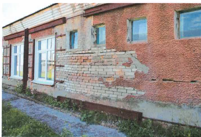
Фото 8.1.1,8.1.2 Выпучивание наружной версты кладки стены
