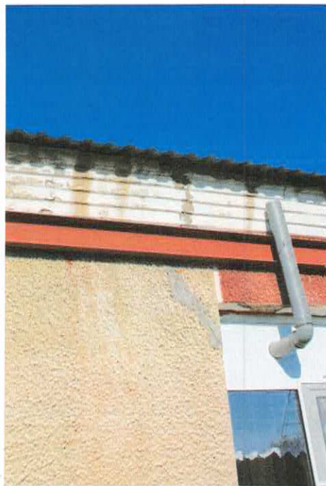
Фото 8.1.13-8.1.15 Трещины в кладке наружных стен и фронтона
