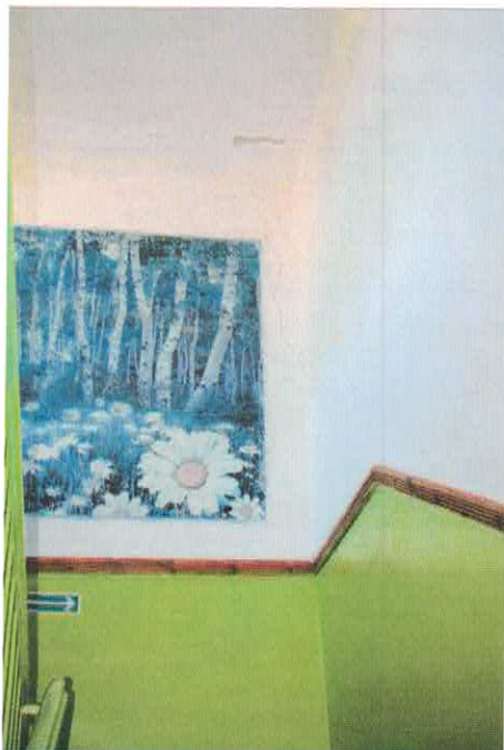
Фото 8.1.16-8.1.18 Трещины в кладке внутренних стен
