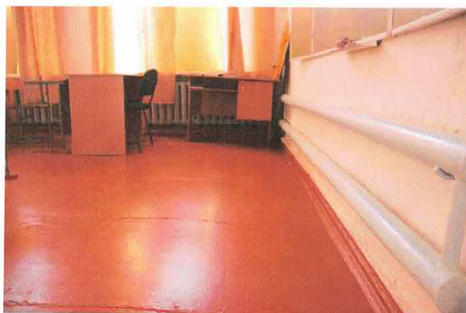
Фото 8.3.3,8.3.4 Деформации дощатого настила пола
