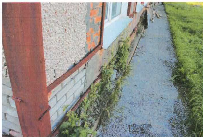
Фото 8.1.9, 8.1.10 Разрушение бетона отмостки, наличие зазоров между отмосткой и цоколем
