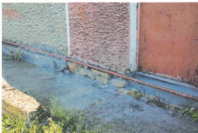
Фото 8.1.1,8.1.2 Наличие пустот в теле бутобетона цокольной части фундаментов
