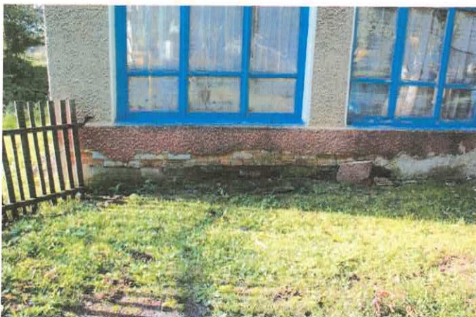
Фото 8.2.1, 8.2.2 Разрушение кладки цокольной части стены одноэтажного пристроя
