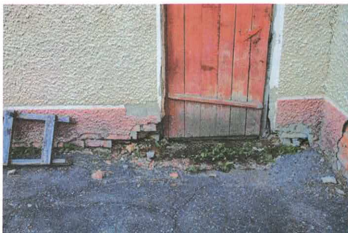
Фото 8.2.5,8.2.6 Разрушение штукатурного слоя и кладки стен одноэтажного пристроя
