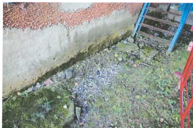
Фото 8.1.1, 8.1.2 Отсутствие и разрушение отмостки
