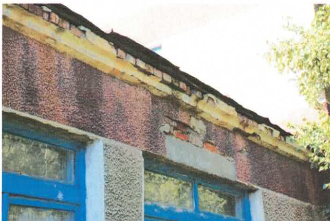
Фото 8.2.5,8.2.6 Разрушение штукатурного слоя и кладки стен одноэтажного пристроя
