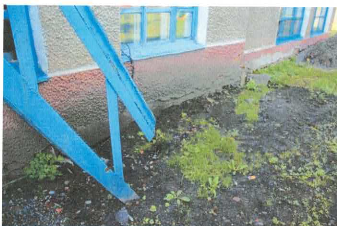
Фото 8.1.1, 8.1.2 Отсутствие и разрушение отмостки
