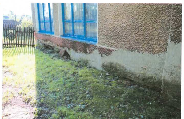
Фото 8.2.1, 8.2.2 Разрушение кладки цокольной части стены одноэтажного пристроя
