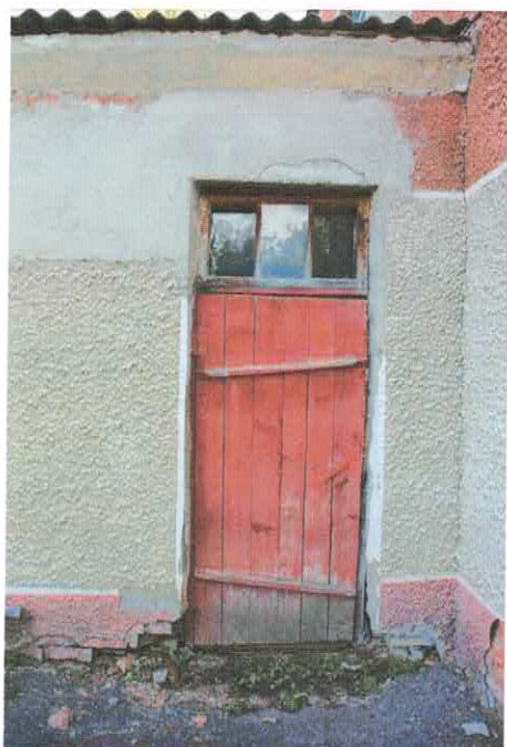
Фото 8.7.5-8.7.7 Общее техническое состояние деревянных дверных блоков
