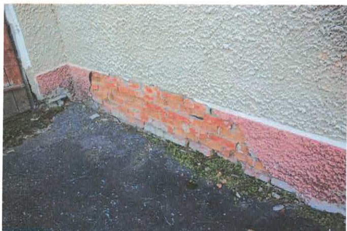
Фото 8.2.7,8.2.8 Разрушение штукатурного слоя и кладки стен основного строения
