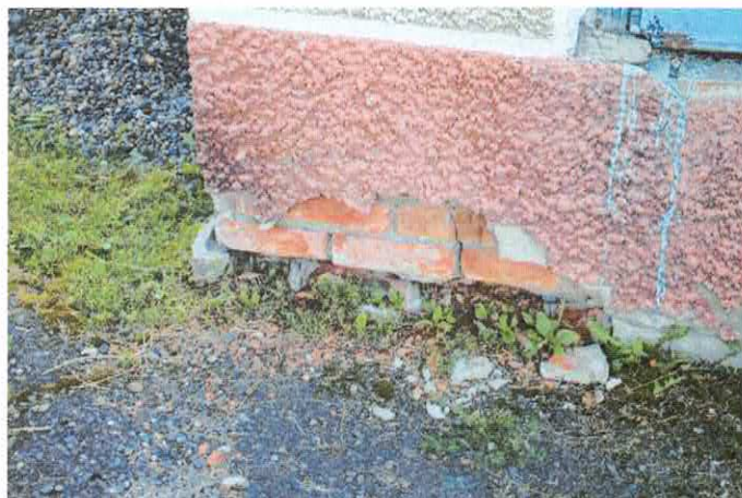
Фото 8.2.3,8.2.4 Разрушение кладки цокольной части стены одноэтажного пристроя
