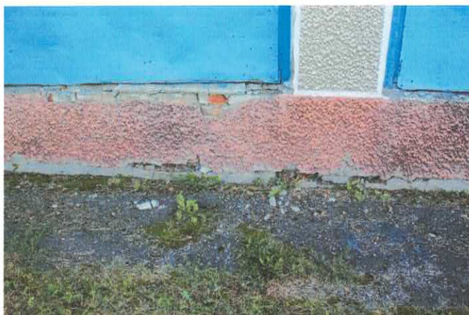
Фото 8.2.3,8.2.4 Разрушение кладки цокольной части стены одноэтажного пристроя
