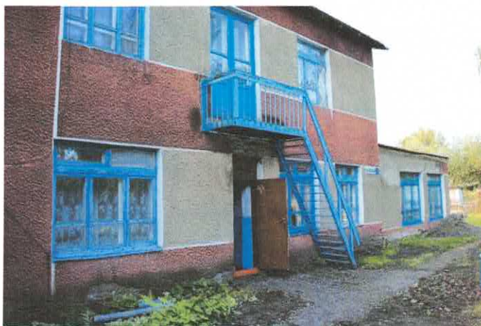
Фото 8.5.3 Общий вид наружной открытой лестницы
