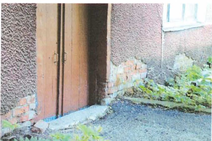
Фото 8.2.7,8.2.8 Разрушение штукатурного слоя и кладки стен основного строения
