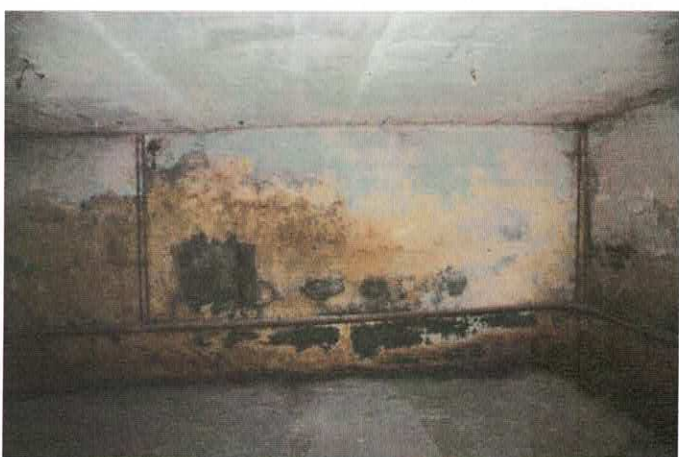
Фото 8.1.9,8.1.10 Признаки систематического замачивания и водонасыщения стен подвала атмосферными осадками, подтопление подвала
