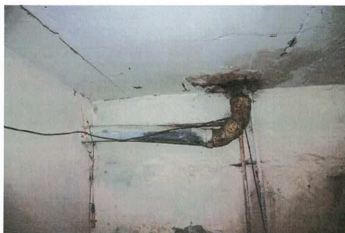
Фото 8.8.3,8.8.4 Коррозия элементов систем водоснабжения и канализации
