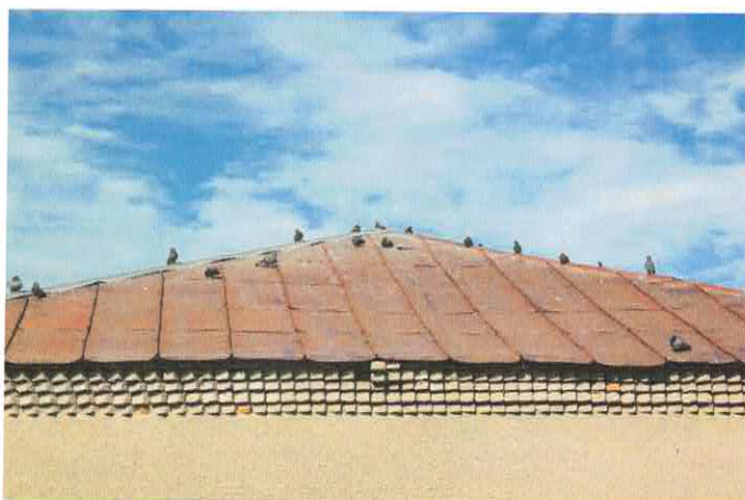
Фото 8.4.1, 8.4.2 Деформации кровельного покрытия, общий физический износ
