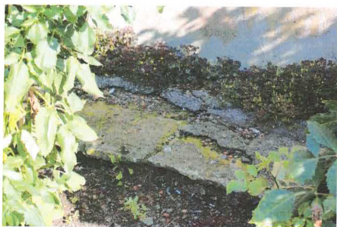
Фото 8.1.11,8.1.12 Разрушение откоски
