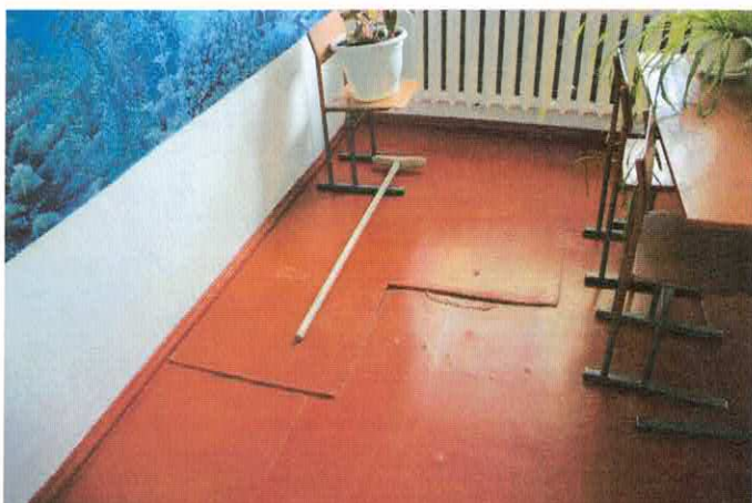
Фото 8.3.7,8.3.8 Деформации дощатого настила пола, общий физический износ покрытия
