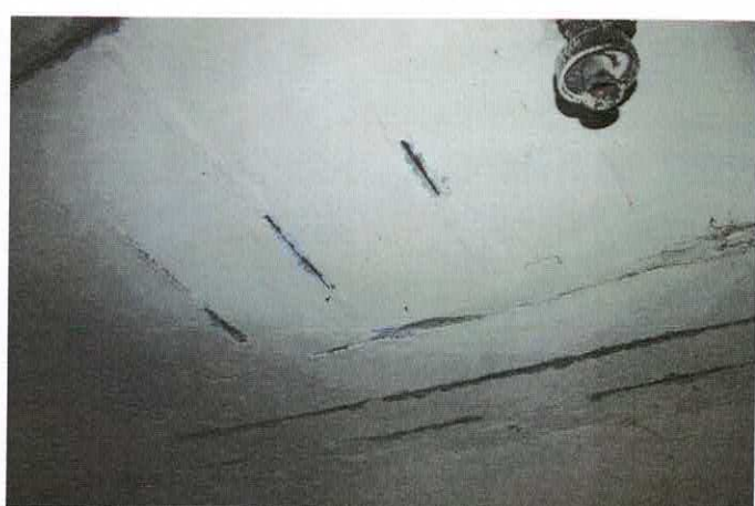
Фото 8.3.3,8.3.4 Разрушение защитного слоя бетона плит перекрытия подвала, коррозия арматуры
