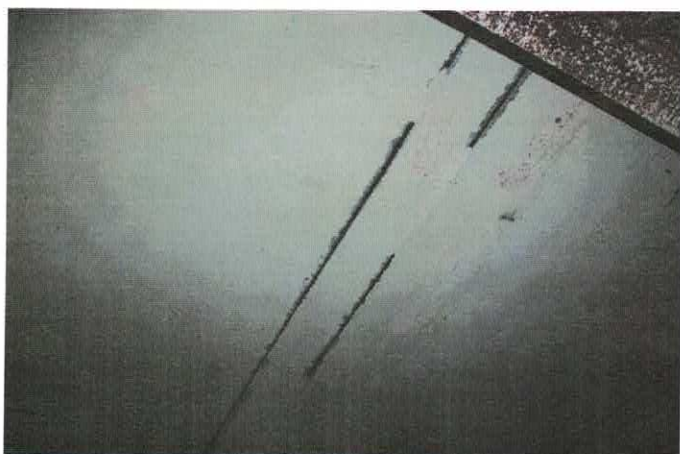
Фото 8.3.1,8.3.2 Разрушение защитного слоя бетона плит перекрытия подвала, коррозия арматуры
