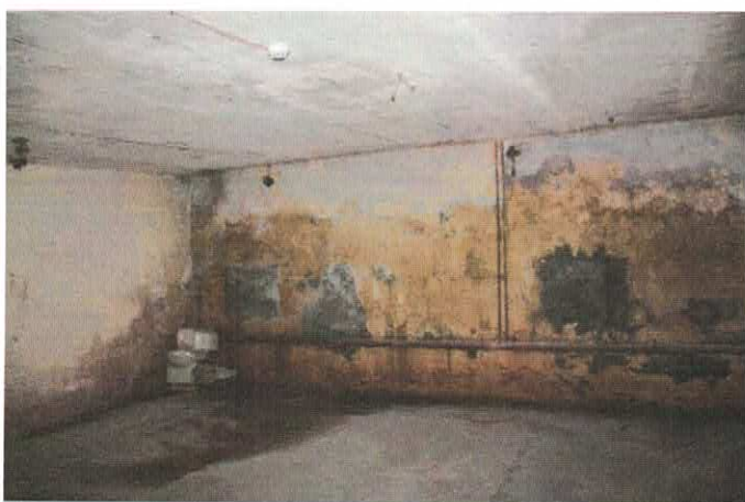
Фото 8.1.9,8.1.10 Признаки систематического замачивания и водонасыщения стен подвала атмосферными осадками, подтопление подвала
