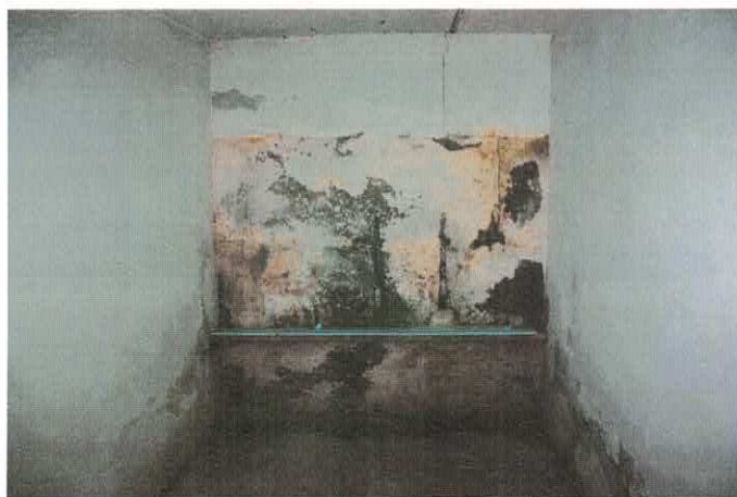
Фото 8.1.7,8.1.8 Признаки систематического замачивания и водонасыщения стен подвала атмосферными осадками, подтопление подвала
