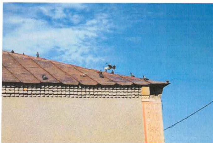
Фото 8.4.1, 8.4.2 Деформации кровельного покрытия, общий физический износ
