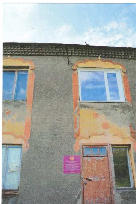
Фото 8.1.7-8.1.9 Трещины в кладке наружных стен
