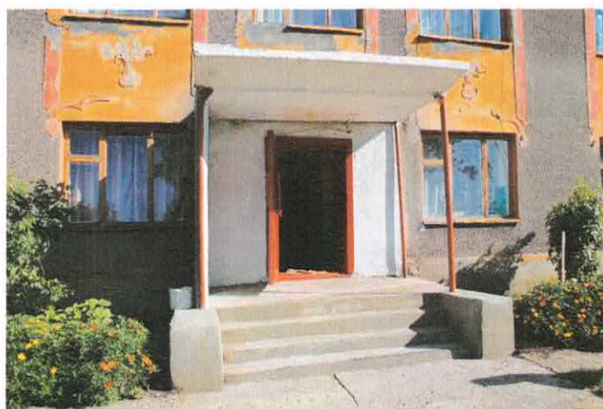
Фото 8.7.1 Общий вид входного узла
