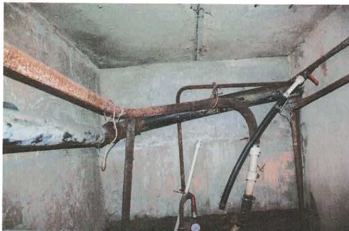
Фото 8.8.1, 8.8.2 Коррозия элементов систем водоснабжения и канализации
