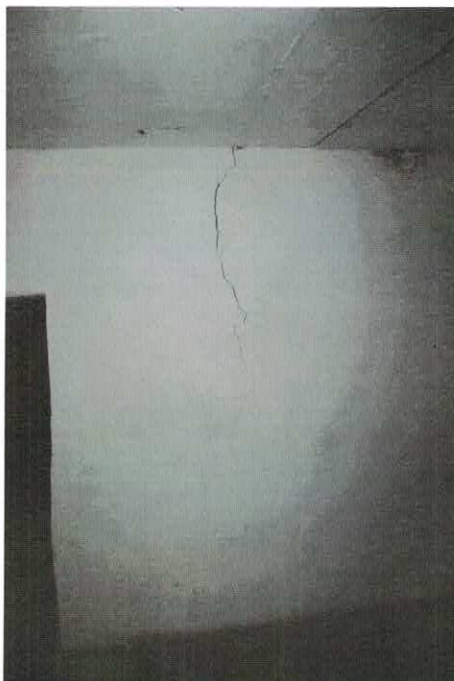
Фото 8.1.1,8.1.2 Трещины в кладке стены подвала
