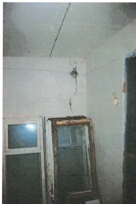
Фото 8.1.1,8.1.2 Трещины в кладке стены подвала
