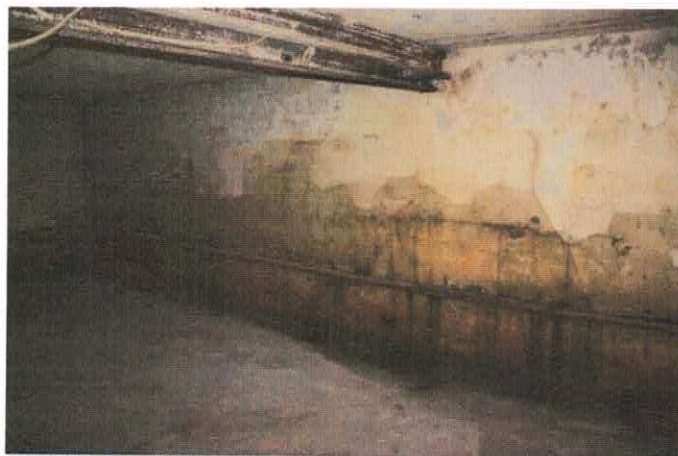
Фото 8.1.3,8.1.4 Признаки систематического замачивания и водонасыщения стен подвала атмосферными осадками, подтопление подвала
