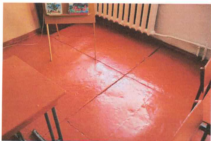
Фото 8.3.9,8.3.10 Деформации дощатого настила пола, общий физический износ покрытия
