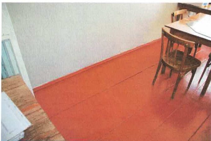
Фото 8.3.7,8.3.8 Деформации дощатого настила пола, общий физический износ покрытия
