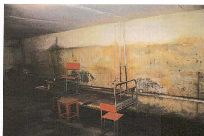
Фото 8.1.5,8.1.6 Признаки систематического замачивания и водонасыщения стен подвала атмосферными осадками, подтопление подвала
