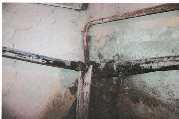
Фото 8.8.1, 8.8.2 Коррозия элементов систем водоснабжения и канализации
