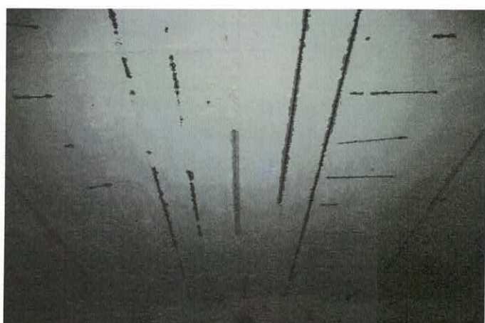
Фото 8.3.1,8.3.2 Разрушение защитного слоя бетона плит перекрытия подвала, коррозия арматуры
