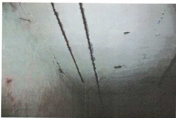
Фото 8.3.3,8.3.4 Разрушение защитного слоя бетона плит перекрытия подвала, коррозия арматуры
