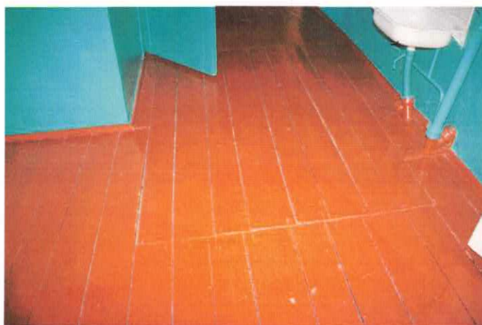
Фото 8.3.5,8.3.6 Деформации дощатого настила пола, общий физический износ
