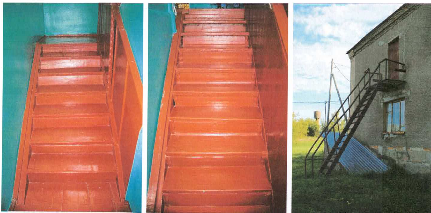
Фото 8.5.1-8.5.3 Общий вид лестничных маршей внутренней лестничной клетки и конструкции наружной открытой лестницы
