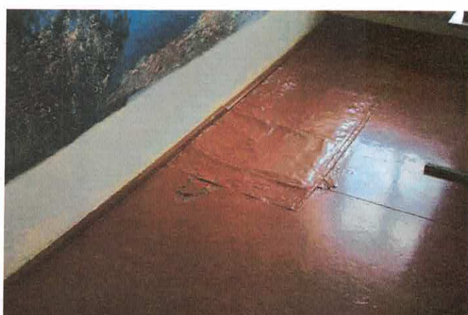
Фото 8.3.9,8.3.10 Деформации дощатого настила пола, общий физический износ покрытия
