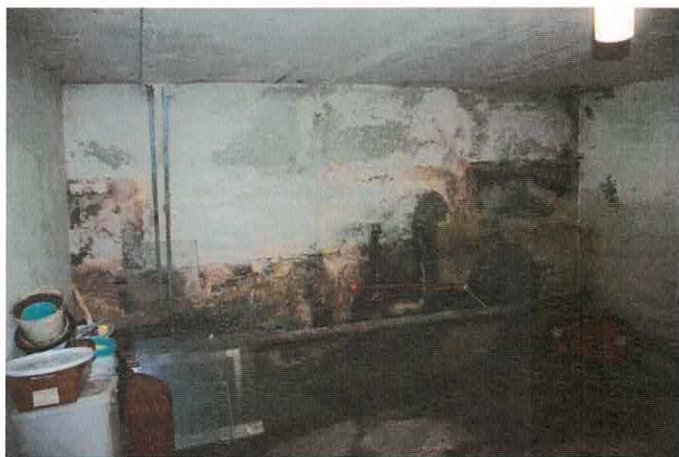
Фото 8.1.7,8.1.8 Признаки систематического замачивания и водонасыщения стен подвала атмосферными осадками, подтопление подвала
