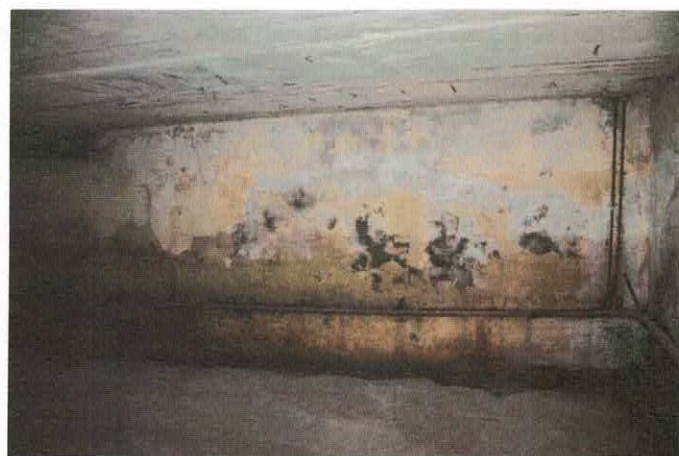
Фото 8.1.3,8.1.4 Признаки систематического замачивания и водонасыщения стен подвала атмосферными осадками, подтопление подвала
