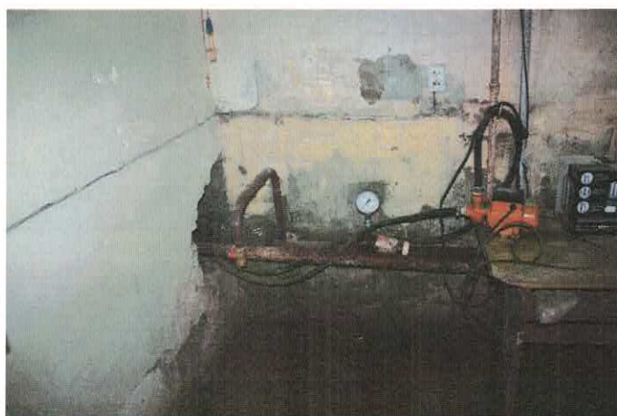
Фото 8.8.3,8.8.4 Коррозия элементов систем водоснабжения и канализации
