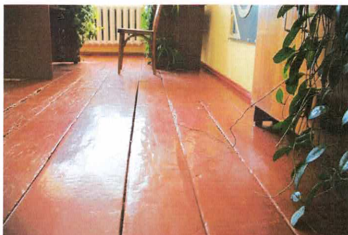
Фото 8.3.5,8.3.6 Деформации дощатого настила пола, общий физический износ
