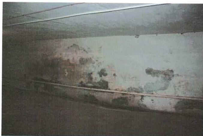
Фото 8.1.5,8.1.6 Признаки систематического замачивания и водонасыщения стен подвала атмосферными осадками, подтопление подвала
