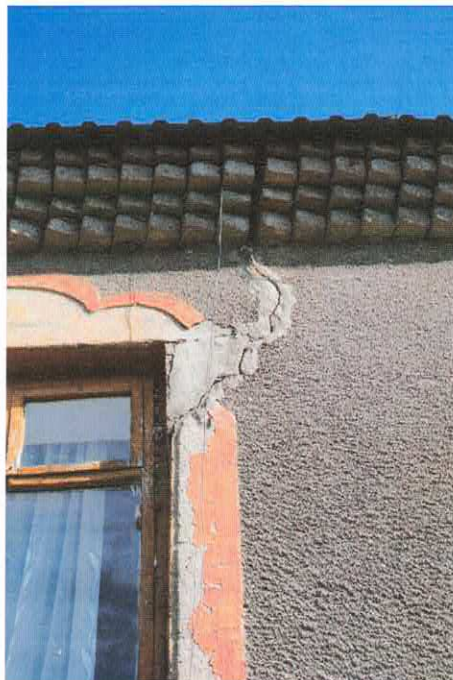
Фото 8.1.4-8.1.6 Трещины в кладке наружных стен
